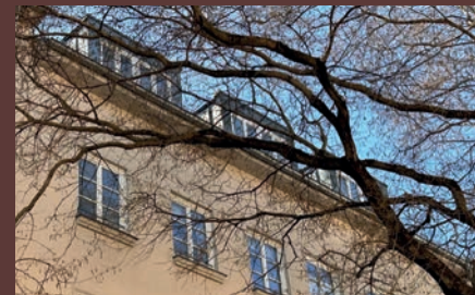
DENKMALGESCHÜTZTER ALTBAU - Ludwigsvorstadt
